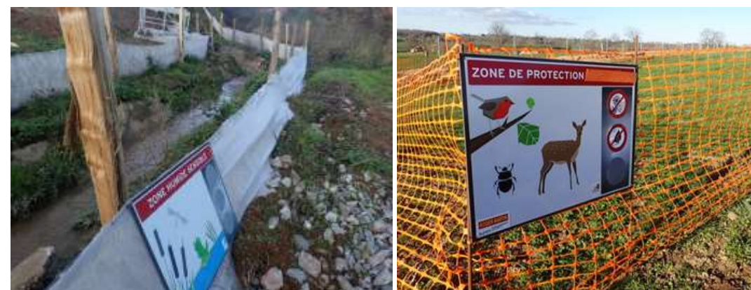
Figure 28. Exemples de mise en défens de zone sensible en phase chantier (Source Crexeco)
