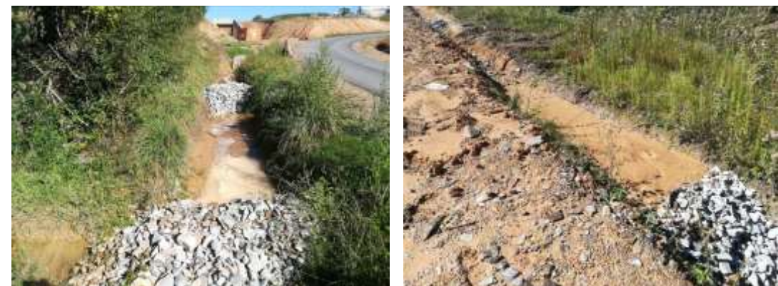
Exemple de fossés temporaires équipés de filtres à cailloux en phase de travaux
